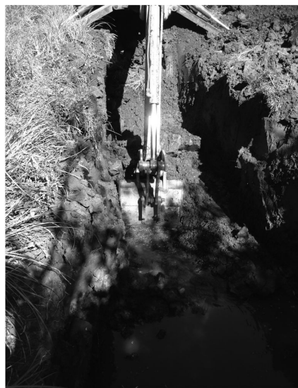
FIGURA 3 - Utilização de retroscavadeira para abertura das trincheiras (AS)
